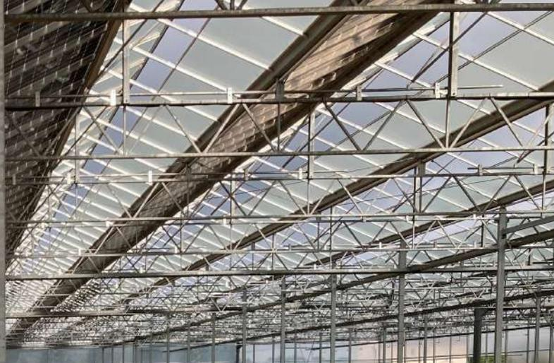
Le module bifacial, avec backsheet transparent, permet une lumière plus diffuse sous la serre photovoltaïque. Cette homogénéité est très appréciée par les plantes.
