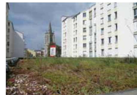
Plante & Cité, Toiture végétalisée à Creil
